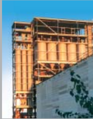
TROCKENBAUSTOFFWERKE DRY MORTAR PLANTS
